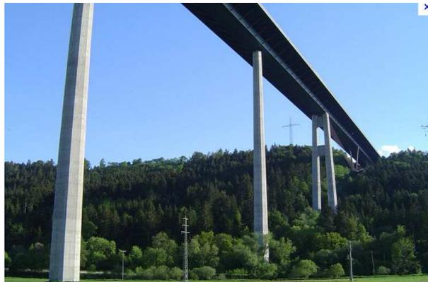
Die **Neckartalbrücke Weitingen** überführt die [Bundesautobahn 81](#) im Abschnitt [Stuttgart–Singen](#) bei [Horb am Neckar](#) vierspurig über den [Neckar](#).
