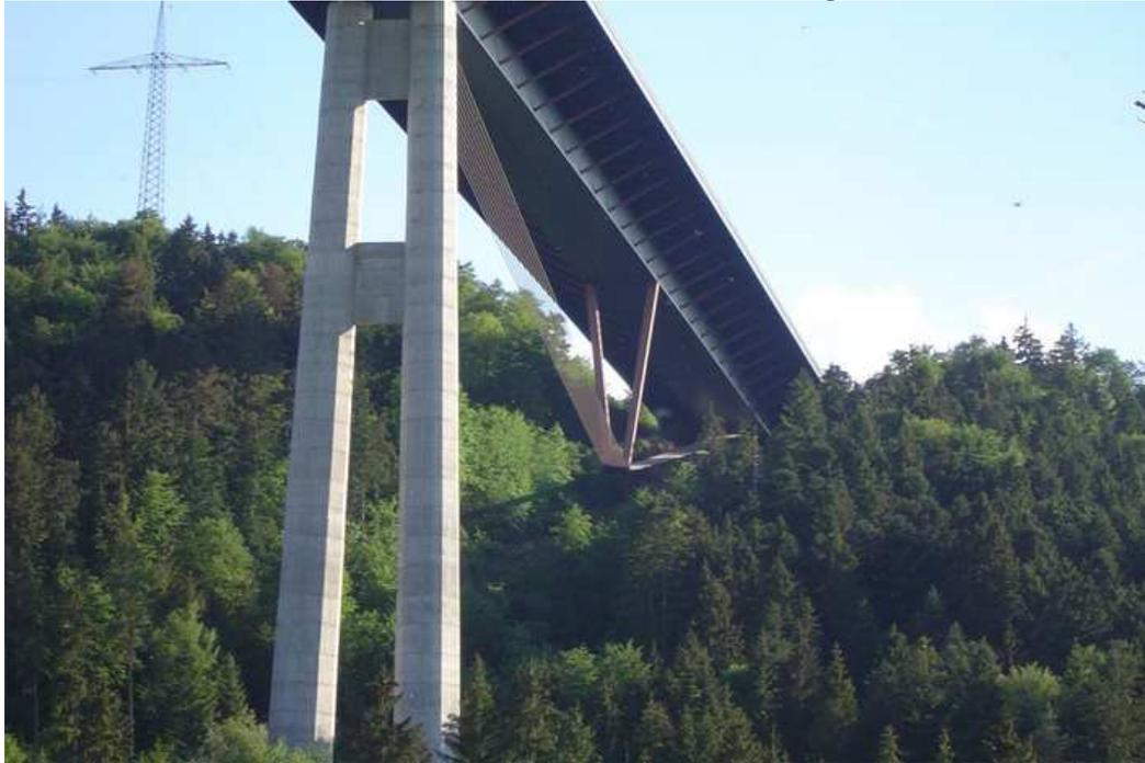
Da der schlechte Baugrund im Hangbereich keine weiteren Pfeiler zuließ, hat die Brücke ihre größten Spannweiten mit 234 m und 264 m in den beiden Aussenfeldern. Damit hatte sie weltweit die zweitlängste Spannweite aller Stahlkastenbrücken. Um diese Spannweiten erzielen zu können, wurden erstmals bei einer derartigen Großbrücke Seilunterspannungen mit 30 m hohen Luftstützen zwischen den Widerlagern und den Doppelpfeilern ausgeführt .
