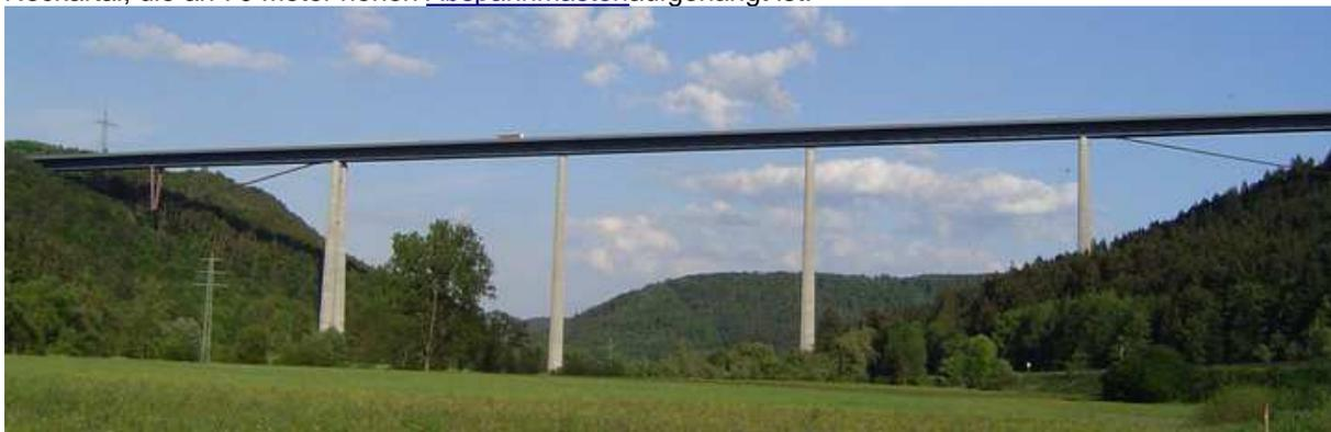
Die hangseitigen Pfeiler wurden als Doppelsäulen ausgelegt, um die gesamten Windkräfte aufnehmen zu können. Die Mittelpfeiler haben lediglich eine Stützfunktion und bestehen aus Einzelsäulen mit kleinem zwölfseitigen Querschnitt.
